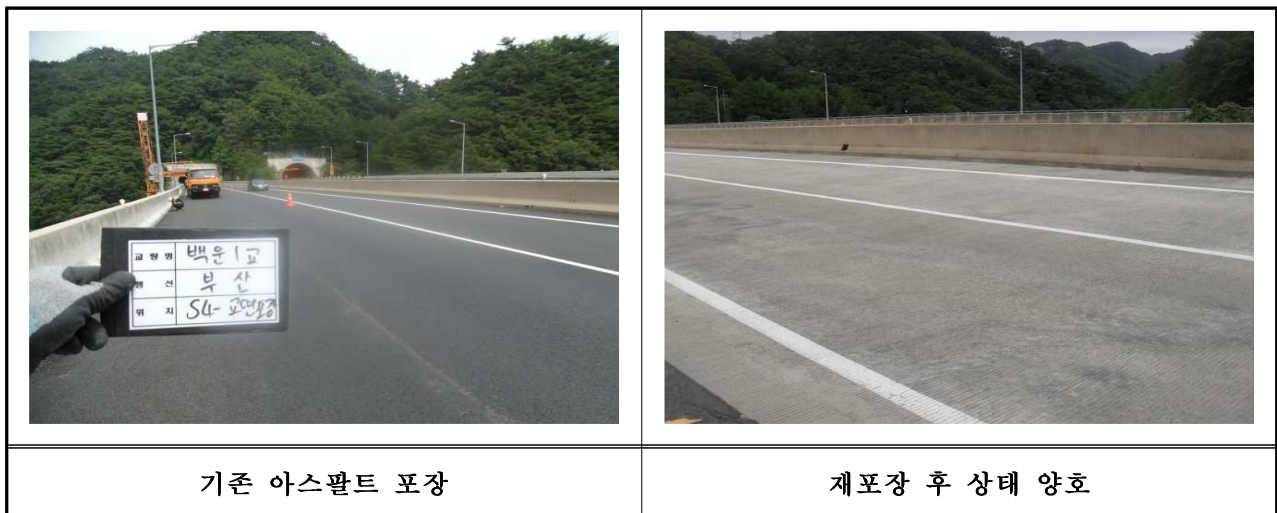
【사진 3.25】 백운1교(부산) 재포장 공사 전·후 전경
