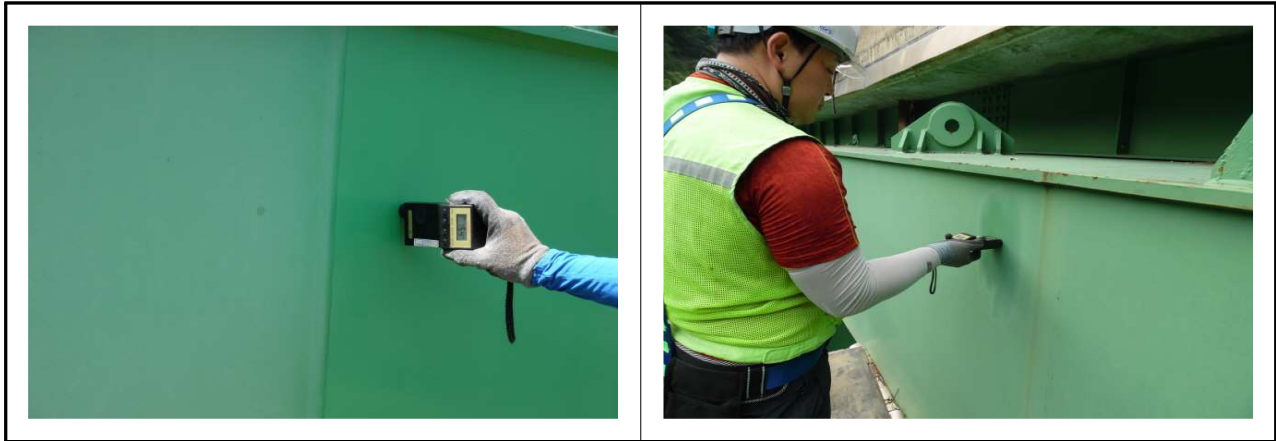
【사진 3.10】 백운1교(부산) 도막두께 측정 전경
