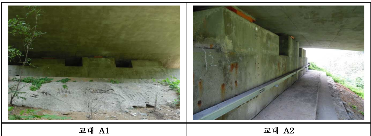
【사진 3.39】 백운1교(춘천) 교대 전경
