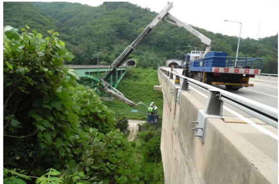
교량점검차 및 이가점검차(다굴절차)를 이용한 외관조사
