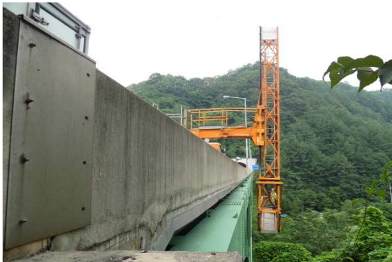
교량점검차 및 이가점검차(다굴절차)를 이용한 외관조사
