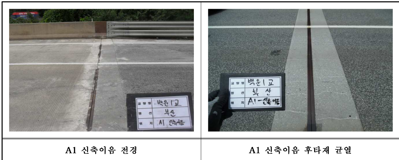
【사진 3.23】 백운1교(부산) 신축이음(A1) 손상 전경
