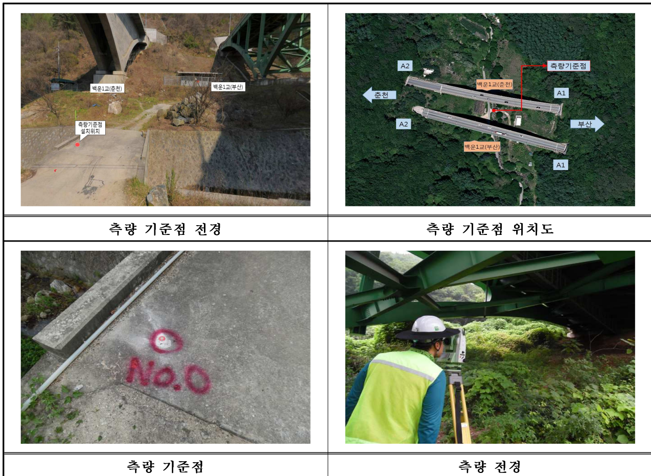
【사진 3.19】 백운1교(부산) 측량기준점 및 측량 전경
