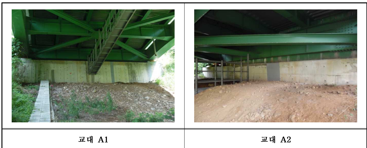
【사진 3.15】 백운1교(부산) 교대 전경
