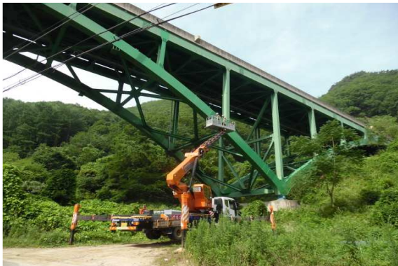
고소점검차 및 디지스코프를 이용한 외관조사
