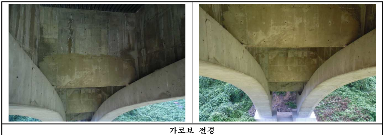
【사진 3.37】 백운1교(춘천) 가로보 전경
