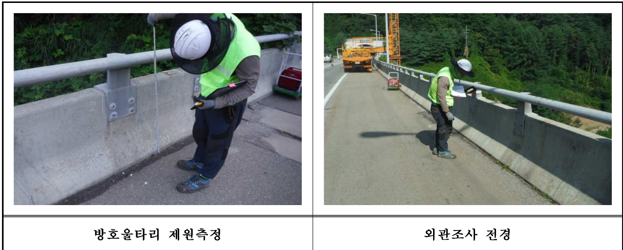
【사진 3.61】 백운1교(춘천) 방호울타리 전경
