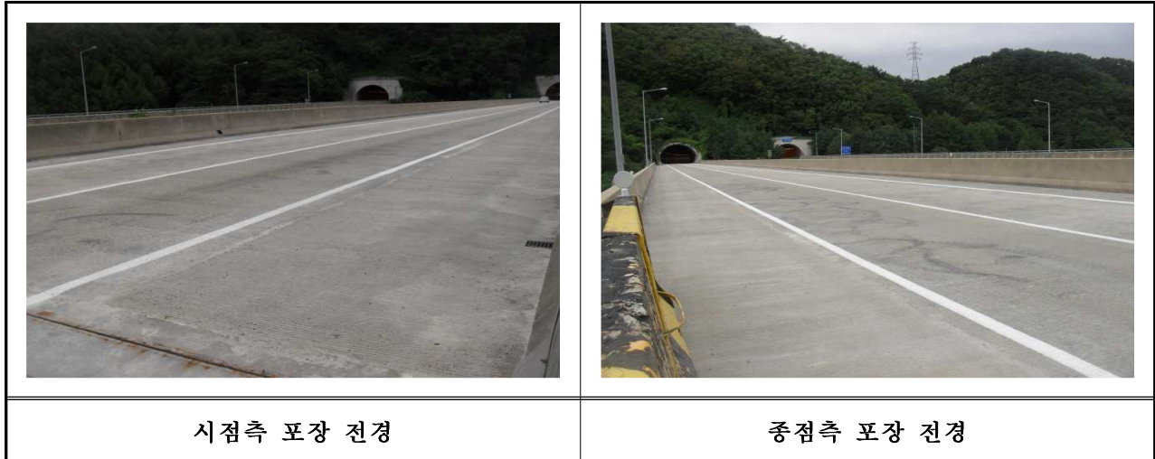
【사진 3.24】 백운1교(부산) 교면포장 전경
