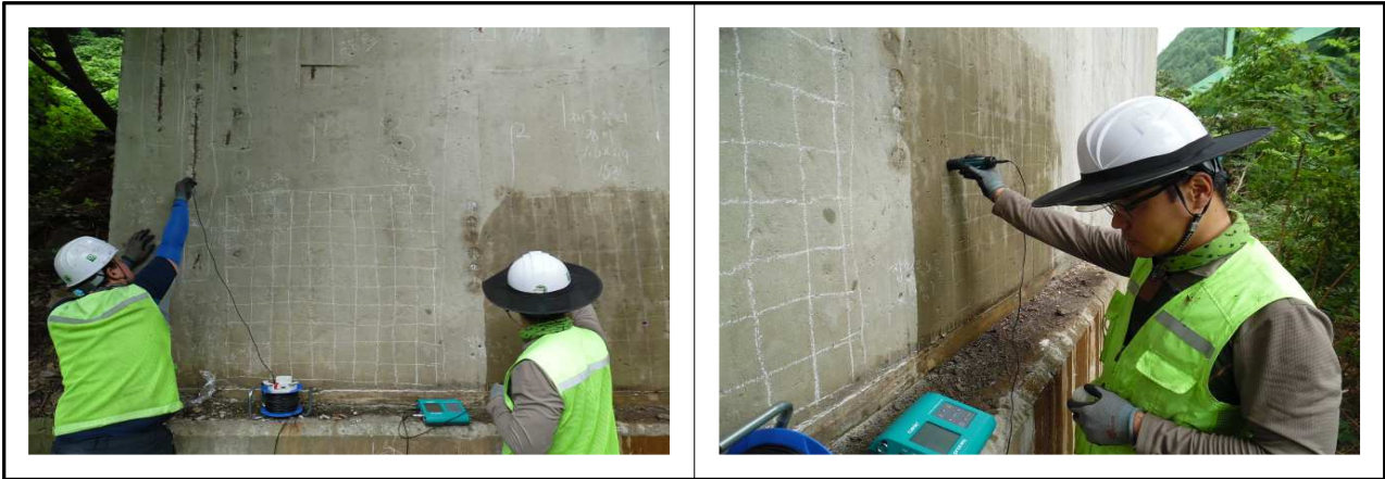
【사진 3.46】 백운1교(춘천) 철근부식도시험 전경
