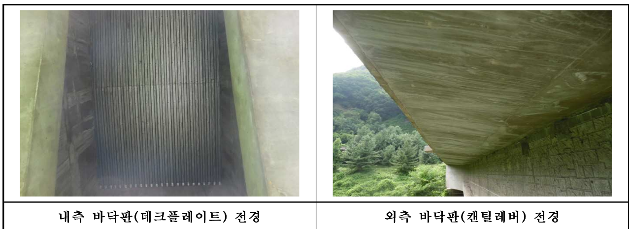
【사진 3.31】 백운1교(춘천) 바닥판 전경
