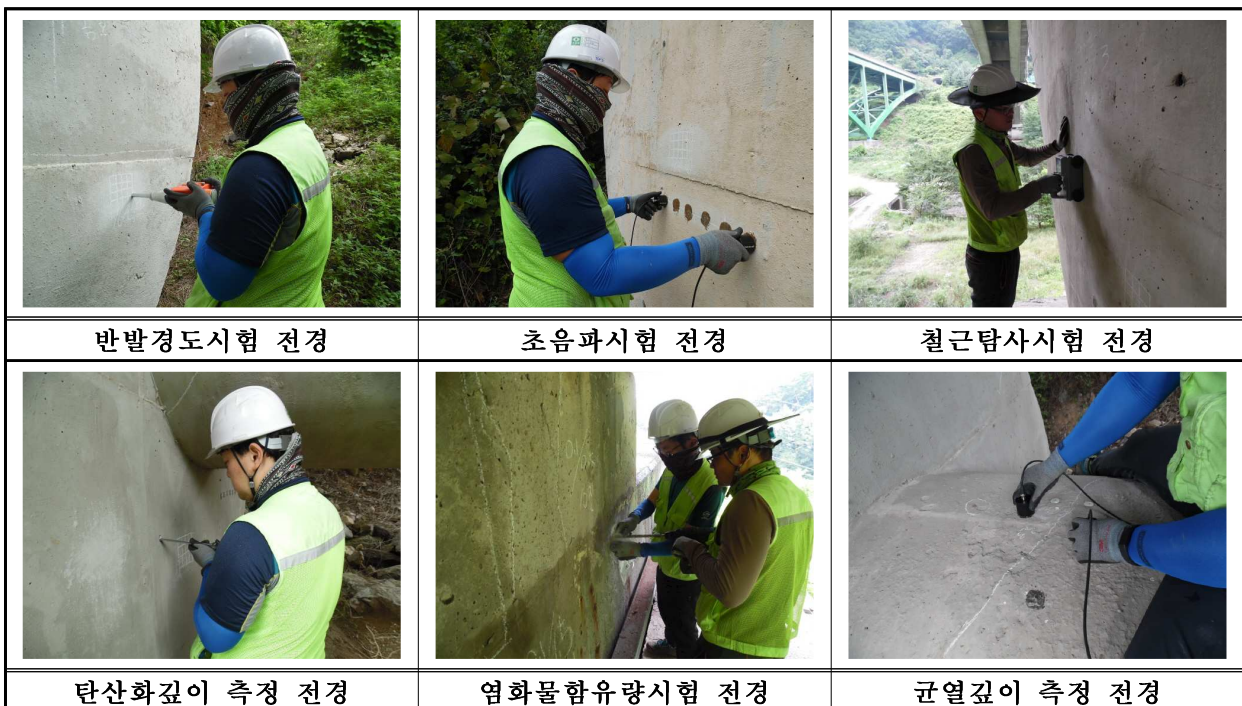
【그림 3.22】 백운1교(춘천) 현장시험 전경
