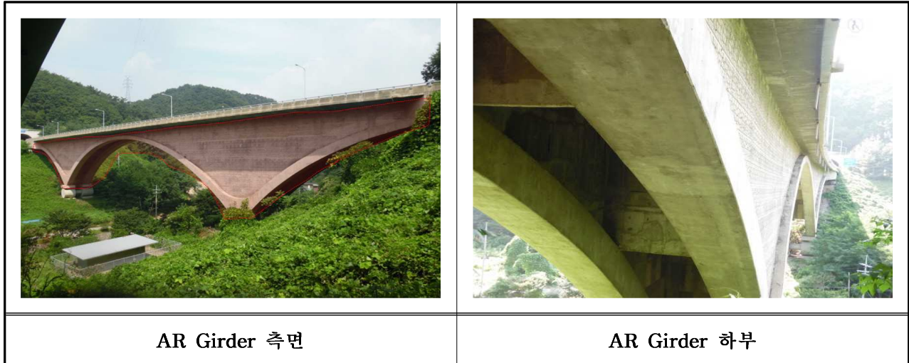
【사진 3.35】 백운1교(춘천) AR Girder 전경
