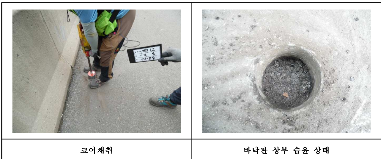
【사진 3.5】 백운1교(부산) 포장부 코어채취 현황
