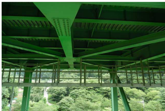
상부 브레이싱 전경
